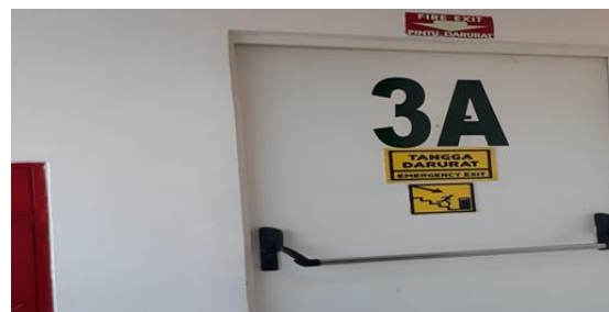
Gambar 9 Pintu Darurat RS Awal Bros
