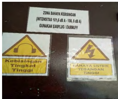
Rambu di Ruang Genset
